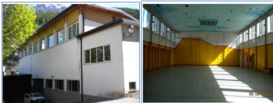
La struttura è in cemento armato, con tetto in orditura metallica e manto di copertura in lamiera zincata preverniciata.
